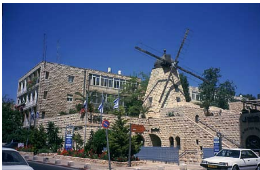
מתן שימוש חדש למבנה ישן: תחנת הרוח ברח' רמב"ן (ביתו של אריך מנדלסון) לפני ואחרי פעולות השימור (באדיבות אדריכל דוד קרויאנקר)
