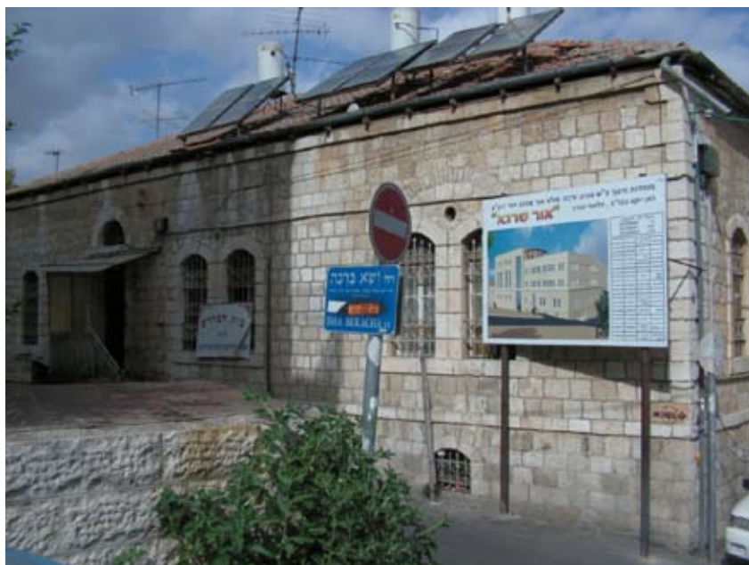
שכונת הבוכרים – שכונה לשימור – מבנה שיועד לשימור
