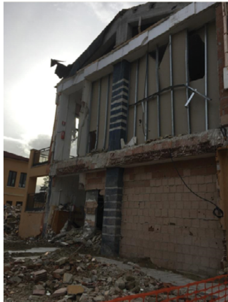
תמונה 2. חציו של בית ספר שחוזק ולא התמוטט ברעידת אדמה באיטליה ב-2016, ולצידו החלק החסר שלא חוזק והתמוטט ברעש (מקור: ירון אופיר מהנדסים בע"מ)
